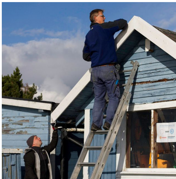
Nya vindskivor på segelförrådet
